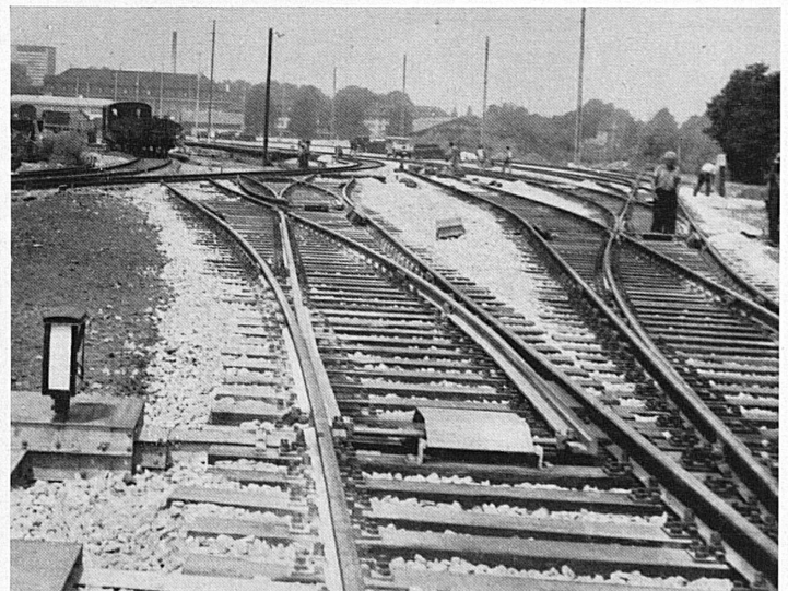
Ausbau Basel GB
