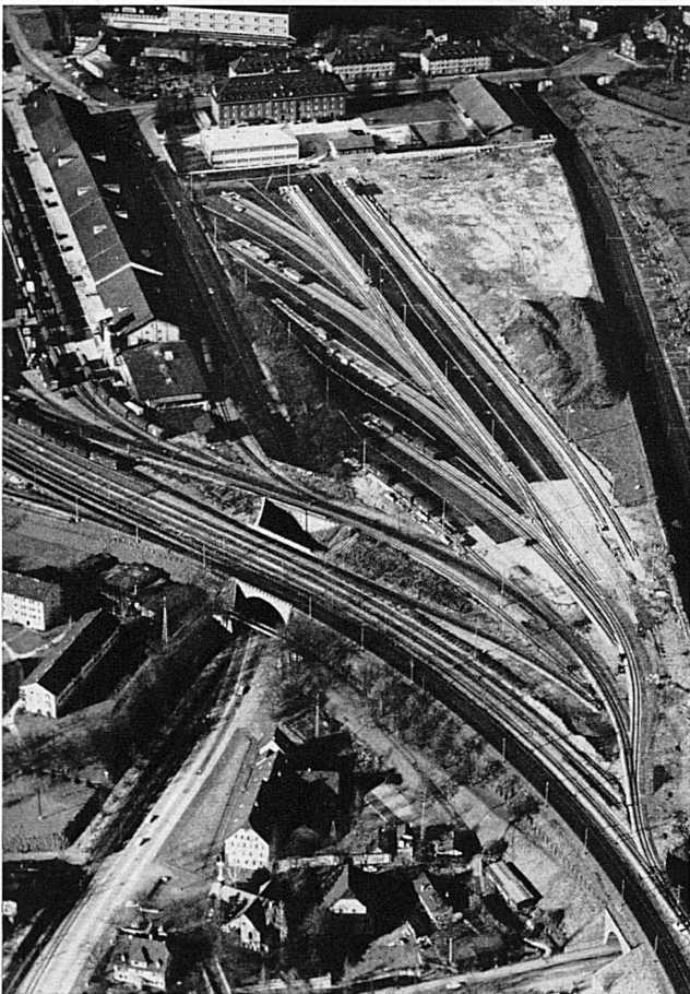
Ausbau Basel GB
