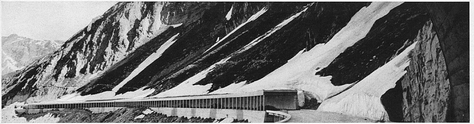
Die 475 Meter lange Galerie der Ganne di S. Antonio, ein Teilstück der neuen Gotthardstrasse. Comet-Photo La galerie des Ganne di S. Antonio, longue de 475 m. C'est un tronçon de la nouvelle route du Gothard La tettoia paravalanghe delle Ganne di S. Antonio, lunga 475 m, sulla nuova strada del S. Gottardo The 1425-ft. long Ganne di S. Antonio gallery, one section of the new Gotthard highway
