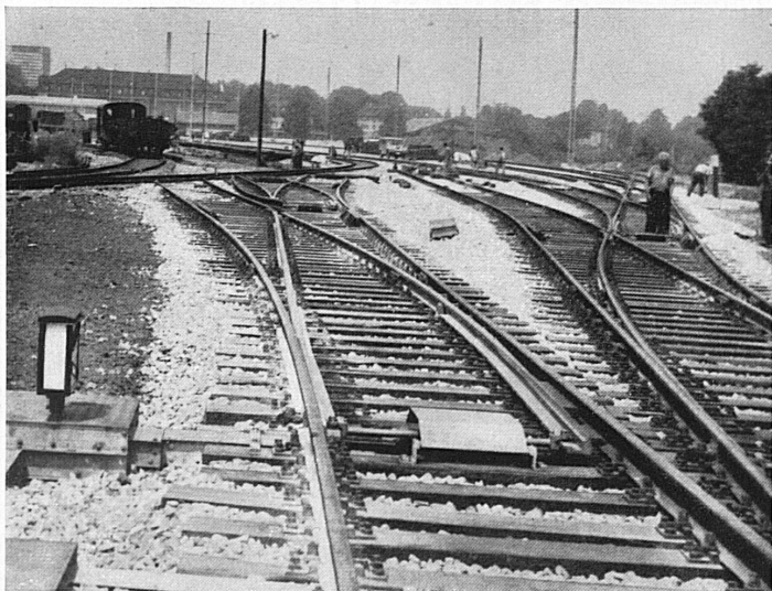
Ausbau Basel GB
