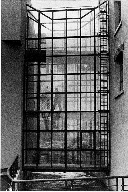
Glas-Eisen-Brücke über den Albanteich
