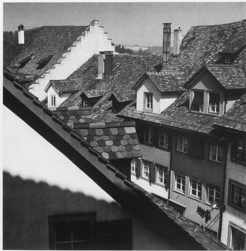
4-6 Dachlandschaften an der Marktasse. Die Marktsiedlung schliesst östlich an die Hofriedung mit Burg (Schloss), Freihöfen und Stiftskirche an. Jenseits des kürzlich renovierten Zeitglocken- oder Bogenturns liegt die Vorstadt, wo sich früher die «lärmigen und stinkenden» Handwerke anzusiedeln hatten
