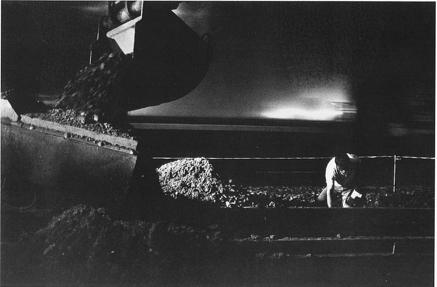
41/42 Weitere Nachtaufnahmen: In gespenstischer Umgebung mühen sich die Gleisarbeiter mit Schotterportionen, Schwellen und Schienenstücke ab – alles eingezwängt in den Rahmen gewaltiger Maschinen und Güterwagenreihen
