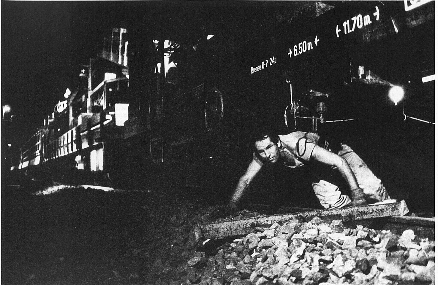
41/42 Altre immagini scattate di notte: in un ambiente quasi spettrale, nell'esiguo spazio fra le gigantesche macchine e la fila di carri merci, gli operai addetti alla posa stendono lo strato di pietrisco e si occupano delle traversine e dei binari
