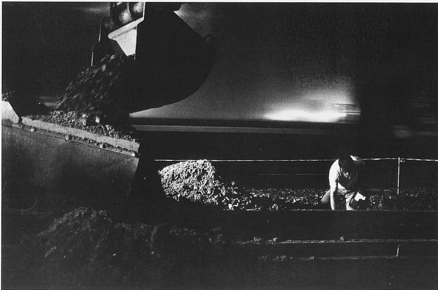
41/42 Weitere Nachtaufnahmen: In gespenstischer Umgebung mühen sich die Gleisarbeiter mit Schotterportionen, Schwellen und Schienenstücke ab – alles eingezwängt in den Rahmen gewaltiger Maschinen und Güterwagenreihen
