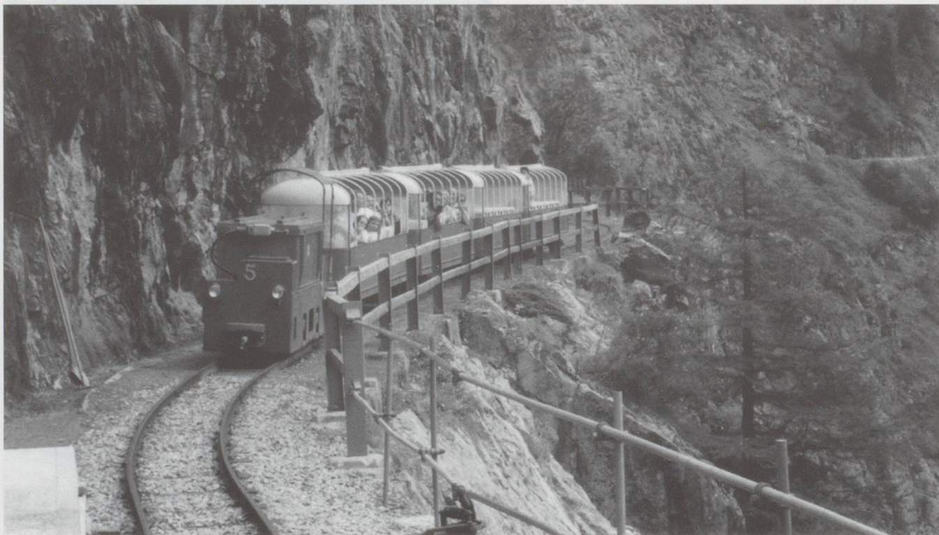
Pied du Barrage: TTE Ta 2/2 No.5 with a train from Château d'Eau
