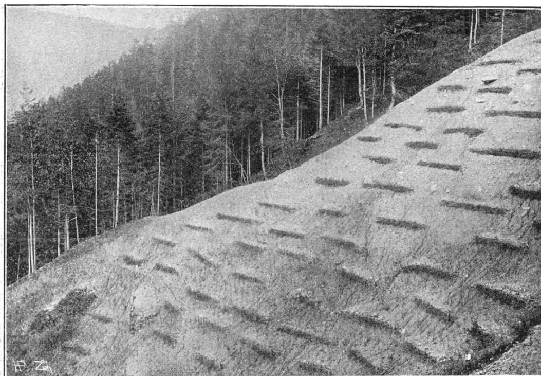
Rétablissement du talus normal clayonnages et barrages (ceux-ci recouverts).
