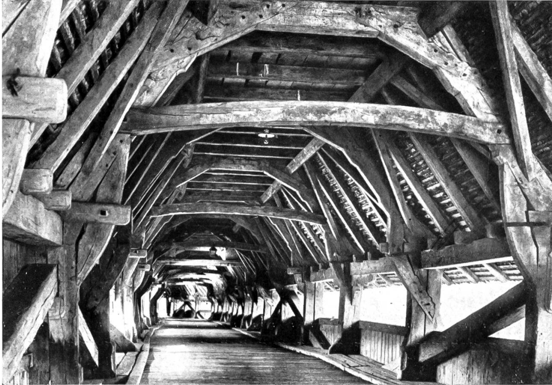
PONT EN BOIS SUR L' AAR, PRÈS DE BERNE, CONSTRUIT EN 1535 Vue de l'intérieur
