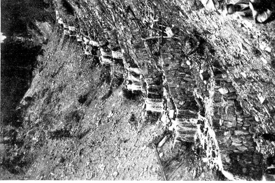
Phot. F. Fankhauser, Kehrsatz. TORRENT DU CHARMAIX, EN SAVOIE. b) Série de barrages, autre vue (1931).
