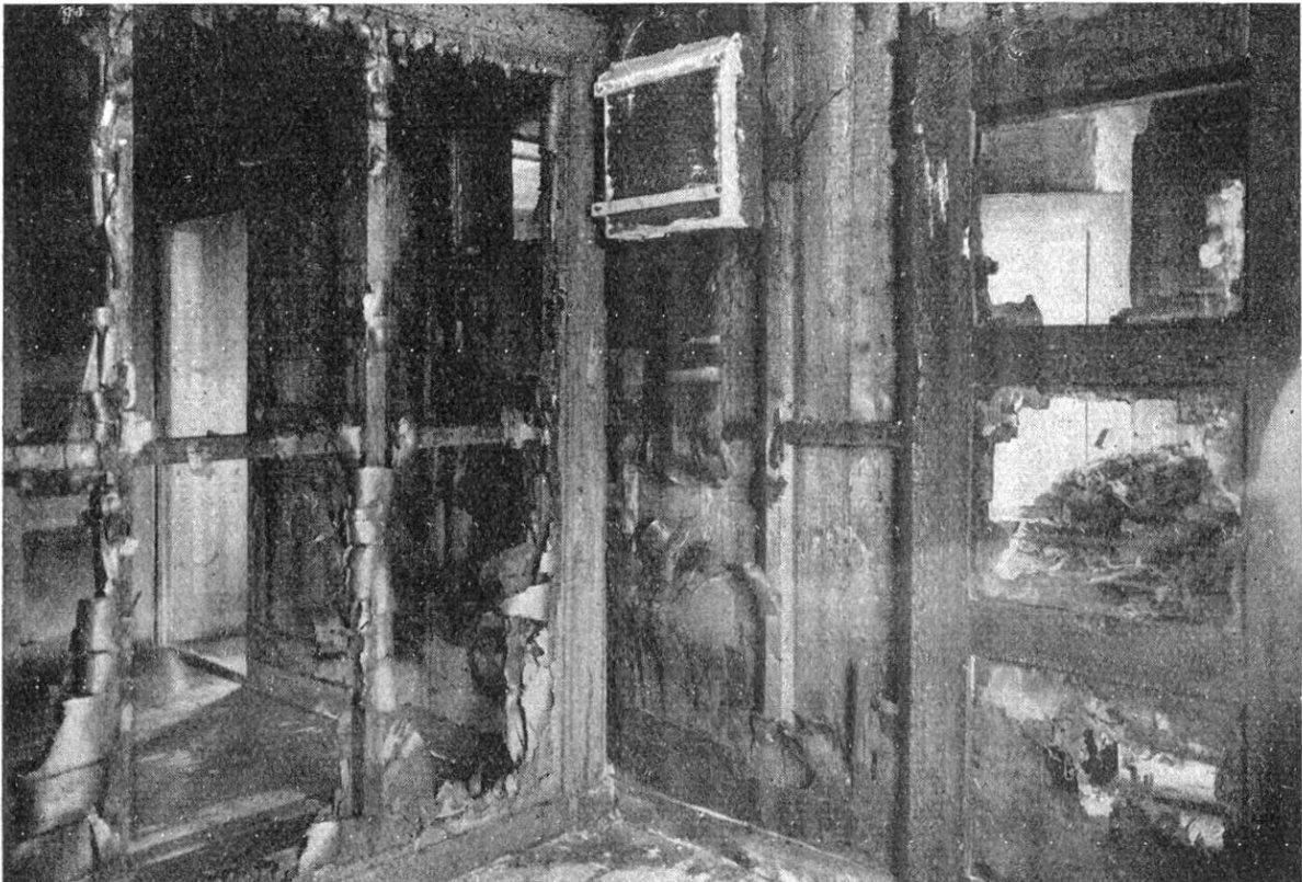
Fig. 3. Influence de l'épaisseur et du pouvoir d'absorption des bois employés. Parois en contreplaqué traité superficiellement, par badigeonnage unique : la destruction est complète. Pièce n° 14, parois A et B.
