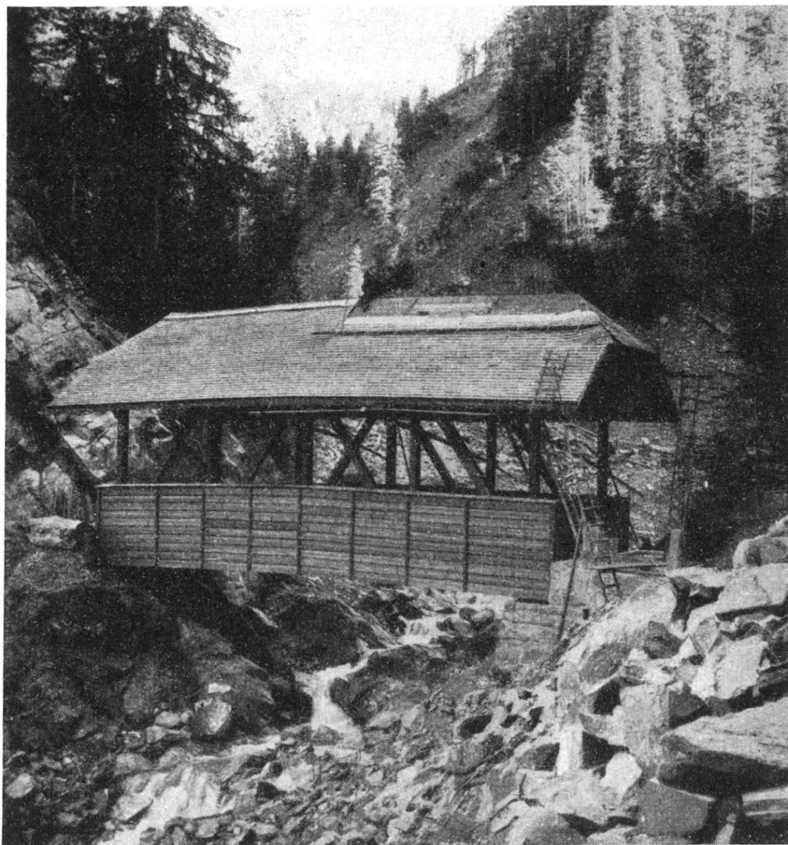
Le pont du Hœllbach, vu de flanc.
