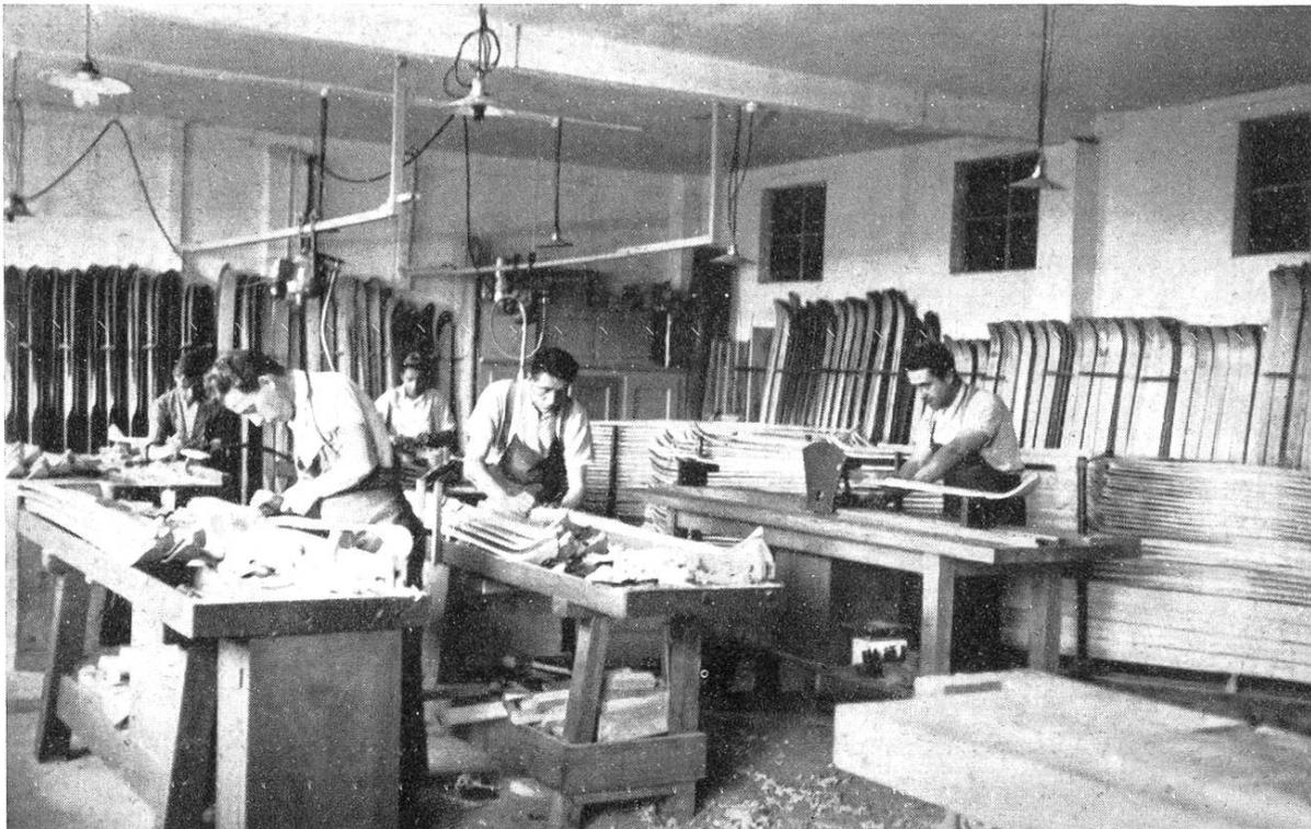
ÉQUILIBRAGE ET FINISSAGE DES SKIS; POSE DES ARÊTES.
