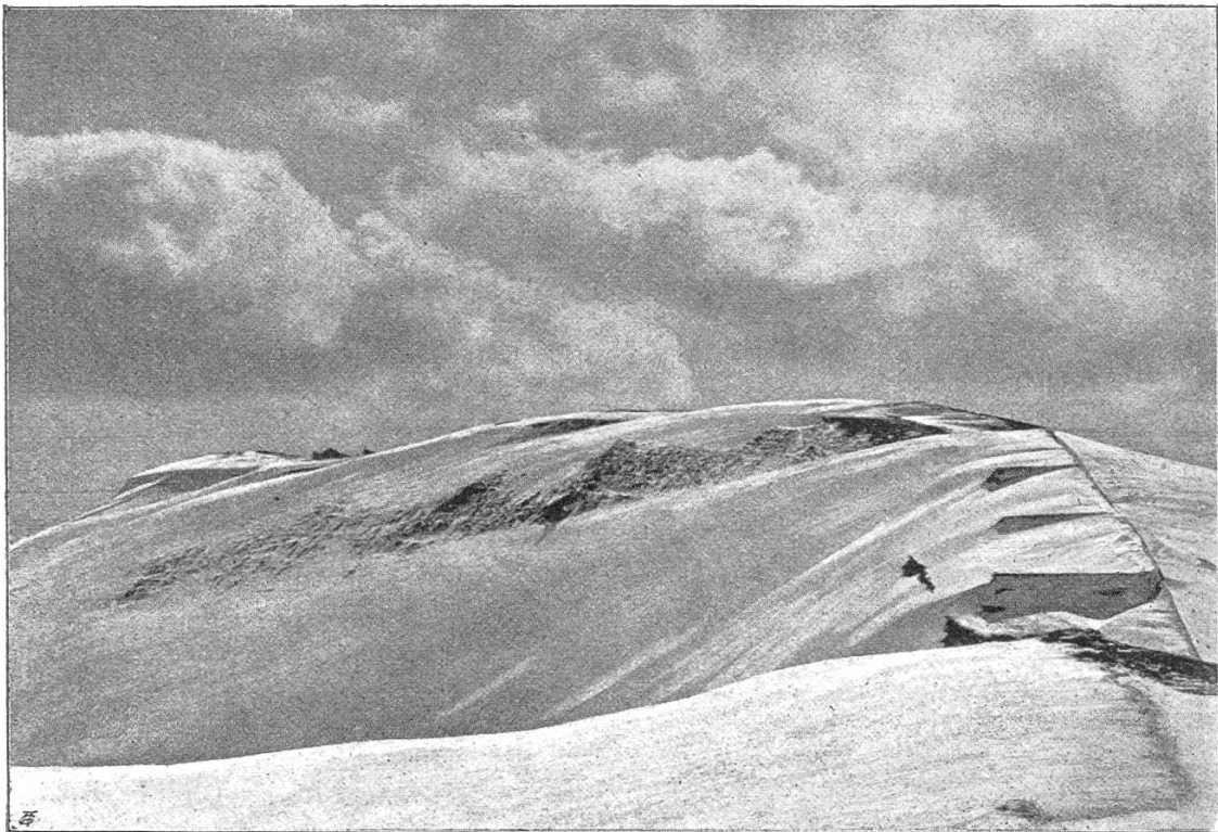
Fig. 6. Schneeablagern vor und hinter dem Lawinen-Schutzdamm.
