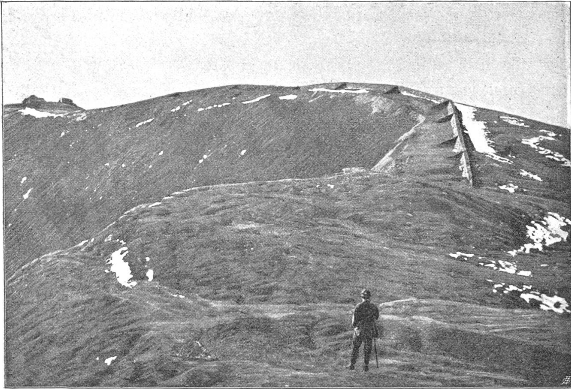
Fig. 5. Lawinen-Schutzdamm auf der Schmittenhöhe.
