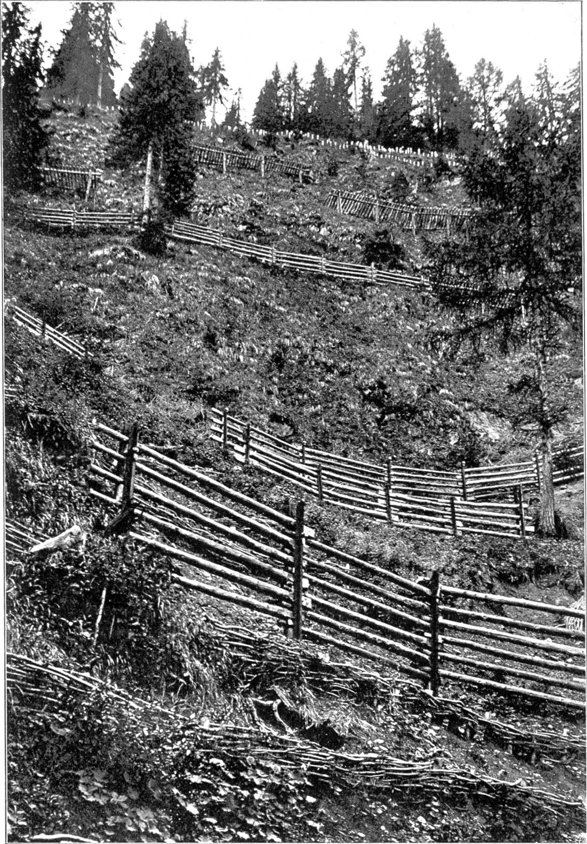
Schneeschutzwände und Schneebrücken im südlichen Zug der Calcestri-Lawine bei Piotta, Km 91,100/300.
