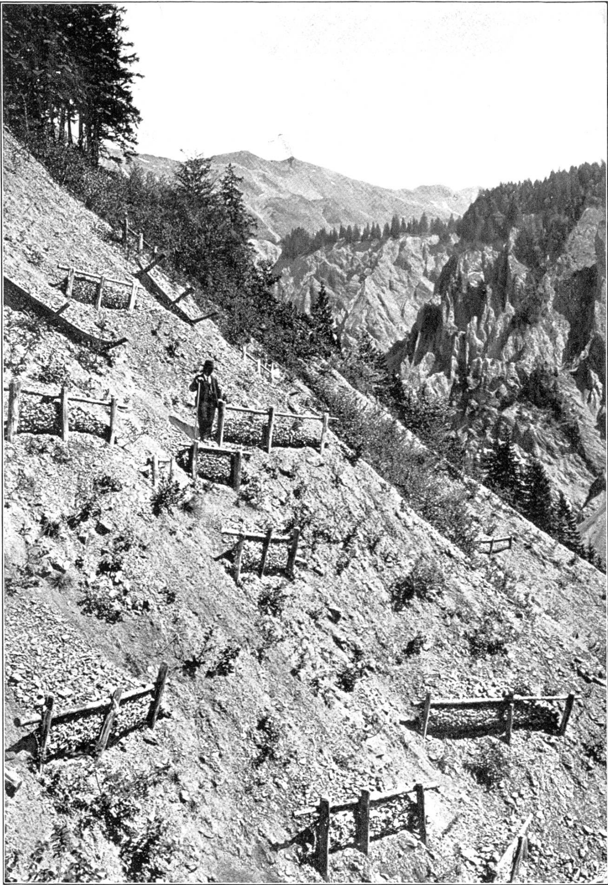
Drahttetter zur Befestigung einer Geröllhalde im Lammbach-Tobel, bei Brienz.
