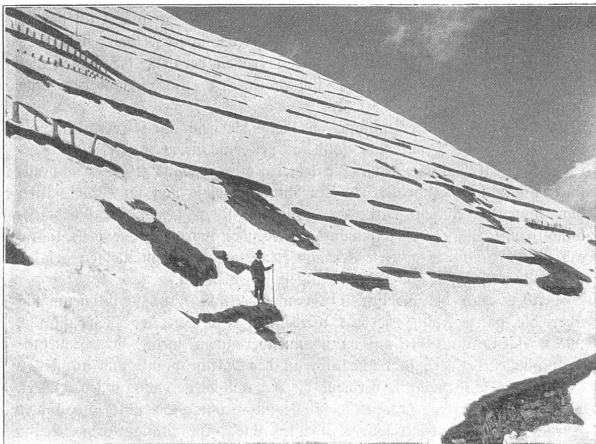
Fig. 5. Weißenplanke bei Elm. Mauerterrassen, gemischte Terrassen und schmälere Terrassen mit Pfahlreihen bei stark zurückgegangener Schneedecke.
