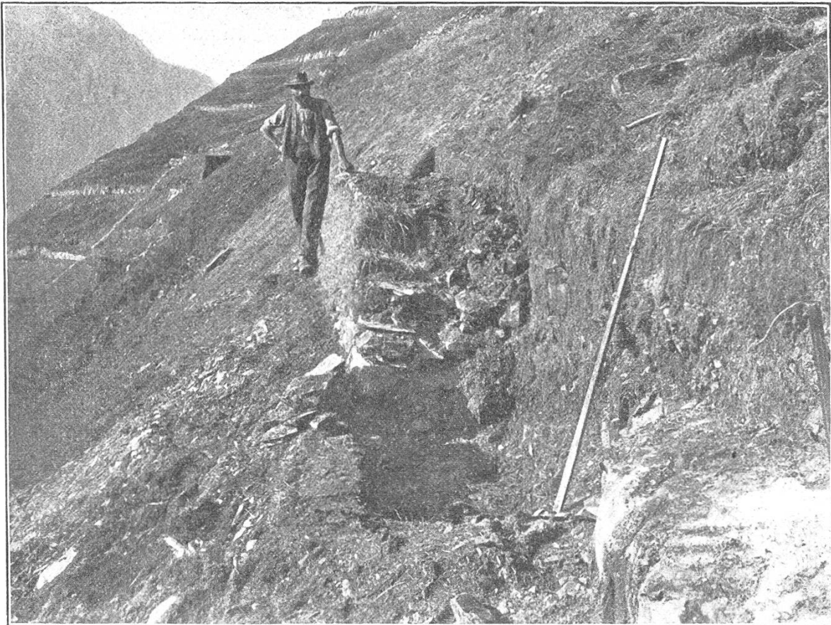
Fig. 2. Meißenplanke bei Elm. Gemischte Terrasse im Bau.
