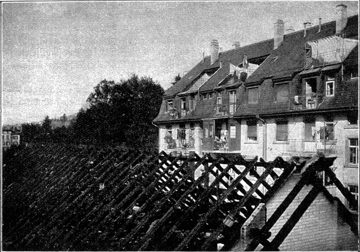
Bild 6. Brandobjekt an der Hotelgasse in Zürich 8. Brandfall vom 9. Oktober 1926.
