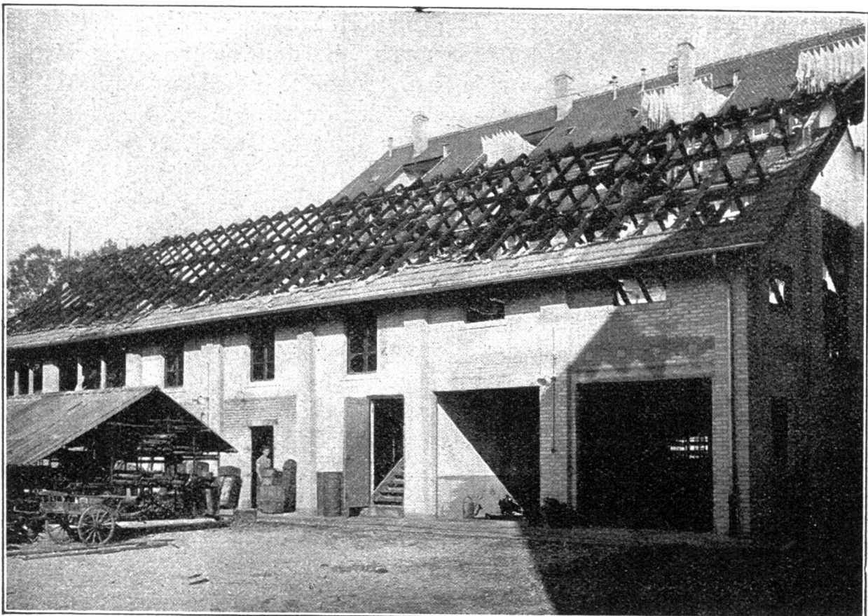
Bild 3. Brandobjekt an der Hotelgasse in Zürich 8. Brandfall vom 9. Oktober 1926.
