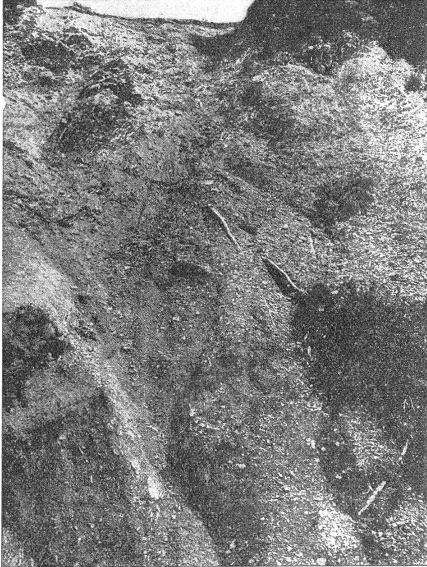
Abb. 6. Die Rutschfläche „Pozze“ im Gebiet des Pontaiba im Jahre 1925.
