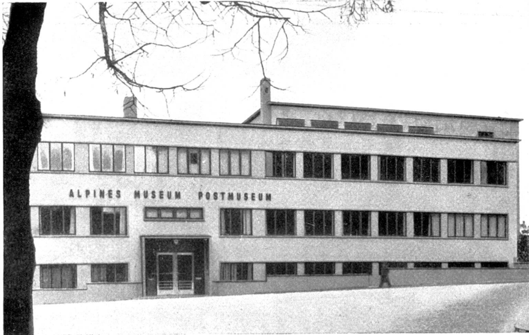
Südfassade. Aufnahme Photodienst der S B B.
