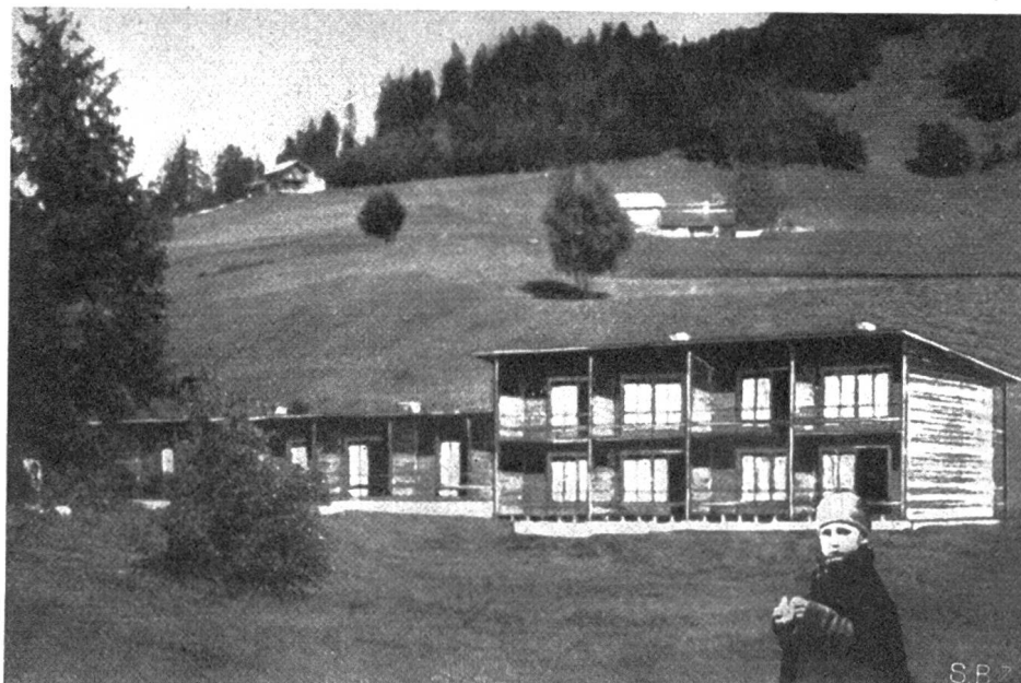
Abb. 8. Ferien-Appartementhaus ( 2 \times 4 ) plus 6 Einheiten kombiniert. Entwurf Architekt BSA Ernst F. Burckhardt. Ausgeführt durch die Chaletfabrik Bündner Oberland, Ilanz, in Holzblockbau nach eigenem patentierten System.
