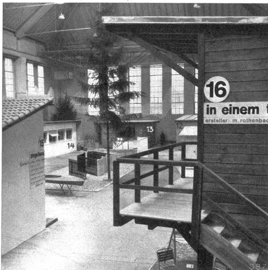
Abb. 1. Blick in die Abteilung „Das Haus“.
