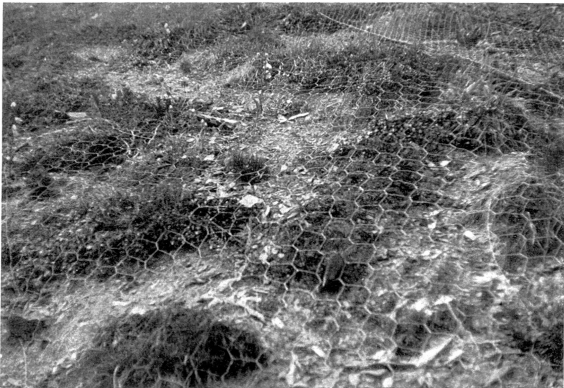
Abb. 6. Aufforstung „Clavadatsch“ (Nr. 12), Gras-(Rasenziegel) und Kleinsträucher- kultur unter Drahtgitter. Schutz gegen Abschwemmung auf steilen, kahlen, leicht verwitterbaren Schiefer- und Mergelböden.
