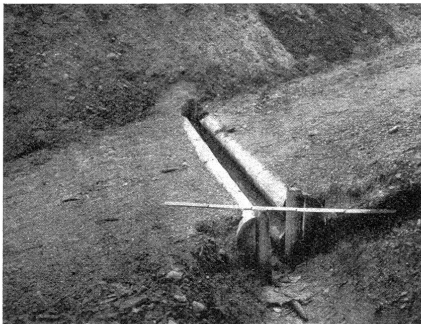
Bild 5. Schlittweg-Wasserabschlag. (Lichtweite 10 statt wie früher 20 cm, dafür doppelte Tiefe durch je 2 Seitenhölzer. Hölzer zirka 30 cm in die Böschung eingelassen.)
