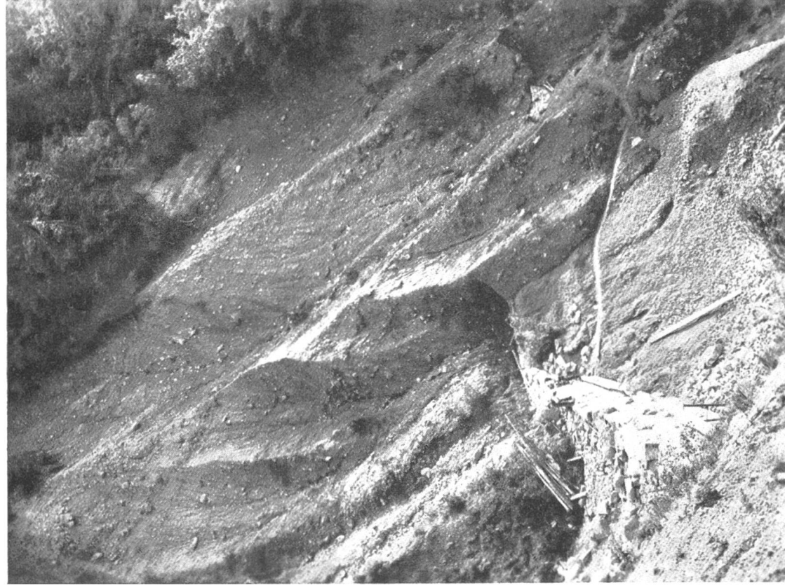
Aufforstung und Verbau der „Buochser-Rübi“, Sektion 2, Korporation Buochs. Bild 6. Vollständig verrückte Seitenlehne im Gebiet der „Buochser-Rübi“ bei Inangriffnahme der Verbauung im Hauptgerinne im Jahre 1934.
