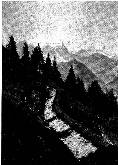
Lawinverbau Schützenrüti, Sisikon. Rasenziegelterrasse von 2 m Breite, Stirnflächenanzug 1 : 40 cm, Planie mit Rückwärtsneigung in der \sphericalangle -halbierenden Zwischen-Senk-rechten zur Hangneigung und der Horizontalen.
