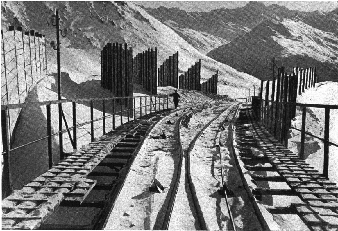
Fig. 6. Ausweichstelle an der obern Sektion der Davos-Parsenn-Bahn mit Leitwänden zur Vermeidung von Schneeablagerungen.
