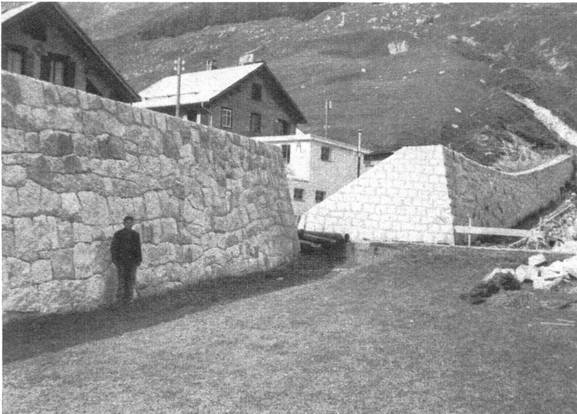
Straßendurchgang zwischen den Mauern II und III
