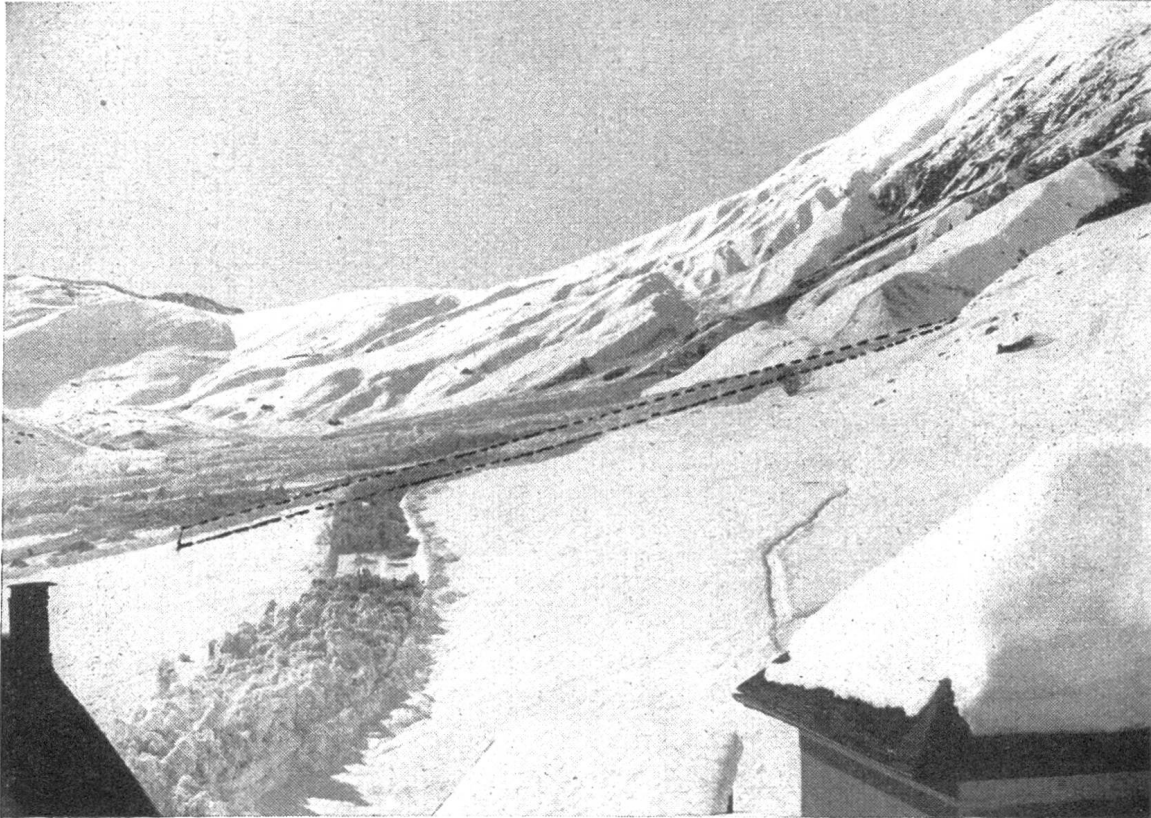
Gspenderlawine Realp, 15. Februar 1928. Rütitallawine vor der Erstellung des Ablenkdammes (-----). Die Lawine griff gegen links aus und glitt mit einzelnen Schollen direkt ins Dörfchen Realp hinein
