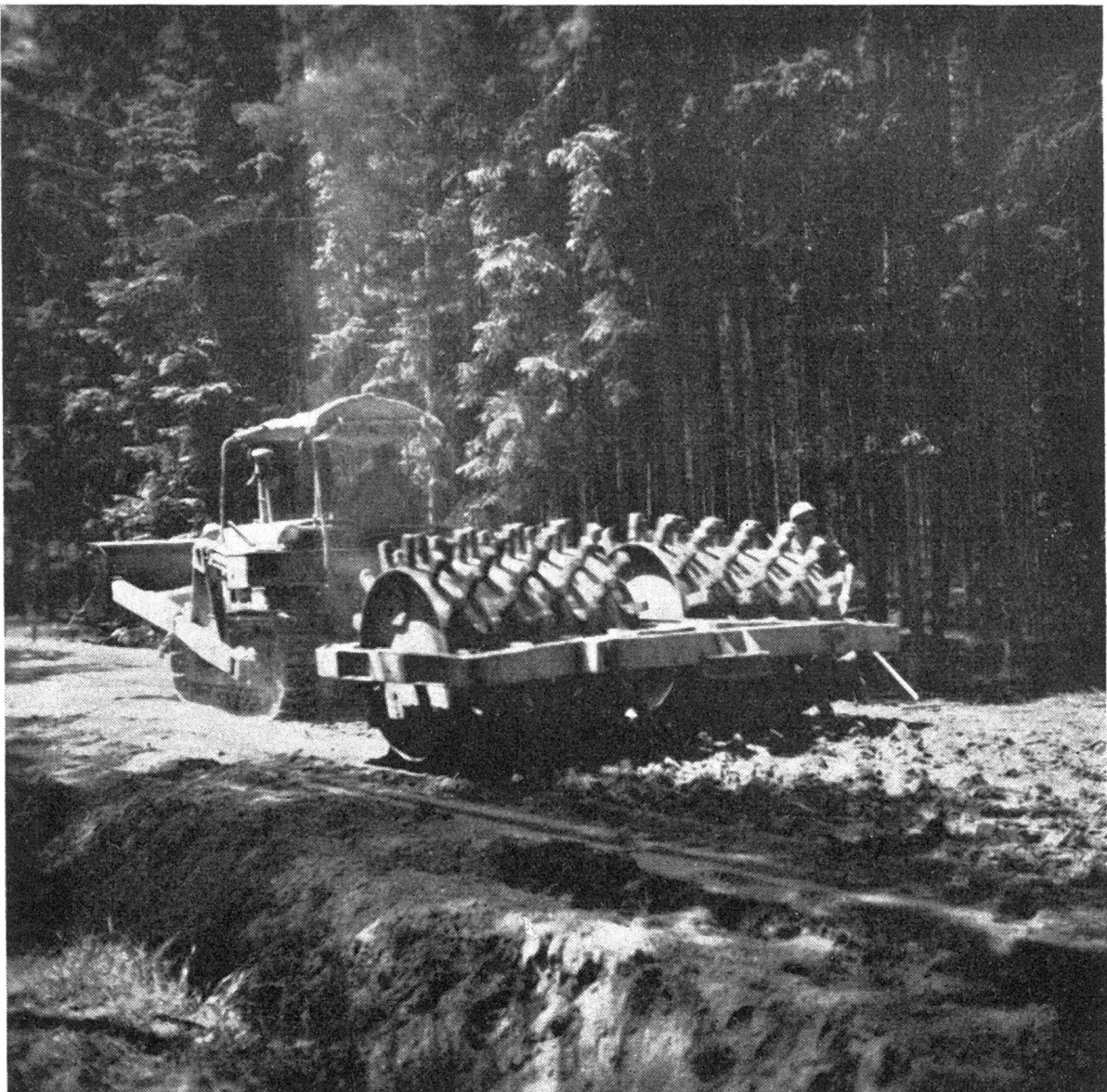
Abbildung 1 Schafffußwalze, von Raupenschlepper gezogen
