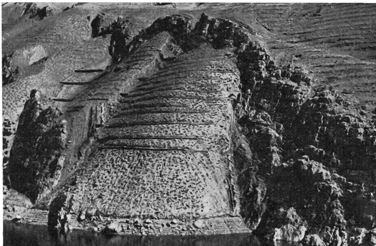
Photo 1. En bordure du lac de retenue du barrage de Karadj; banquettes étroites, banquettes renforcées, murs, seuils.
