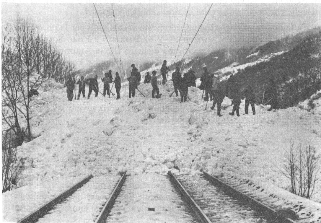
Figura 2. La valanga del vallone del Solco sopra Fiesso, del 10 marzo 1972. Ingombro massiccio della cantonale e della ferrovia
