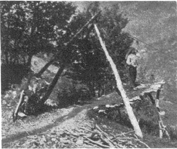
Abbildung 28. Obere Station einer einfachen Drahtriese.
