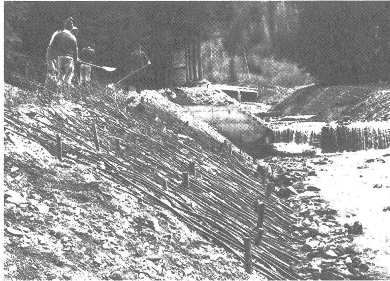
Abbildung 1. Ufersicherung mit Weidenspreitlagen, Lasankenbach- Hinterläsen, Südtirol.
