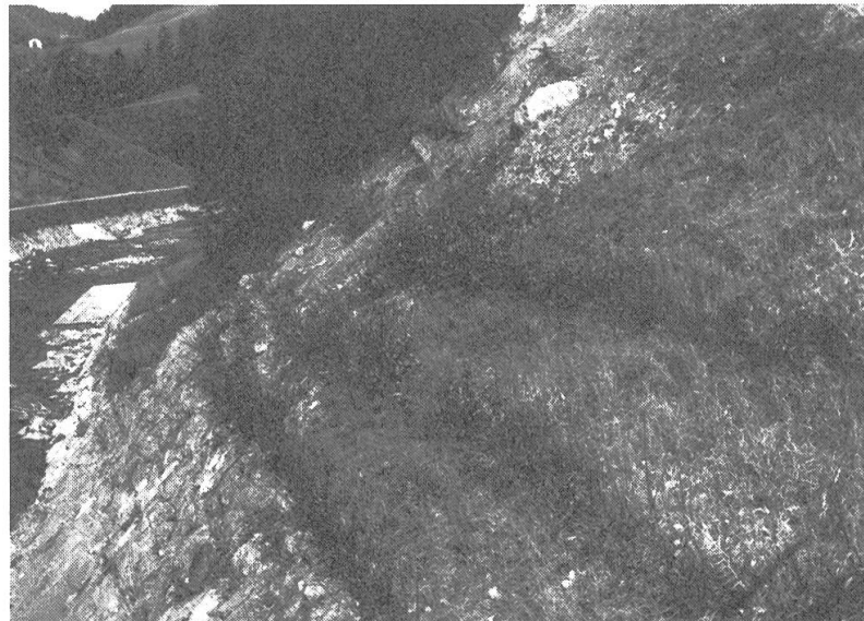
Abbildung 2. Hangsicherung mit Buschlagen, links unten eine Trocken-Steinmauer mit Fugen- bepflanzung durch Weidensteckhölzer, Gader/Pedrares.
