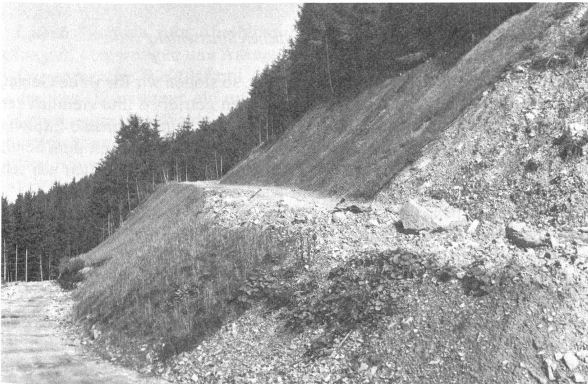
In steilen Gebieten sind die Waldstrassen sehr sorgfältig in das Gelände einzupassen, um hohe, erosionsgefährdete Böschungen und damit schroffe Eingriffe in Wald und Landschaft zu vermeiden. Foto W. Wachter.
