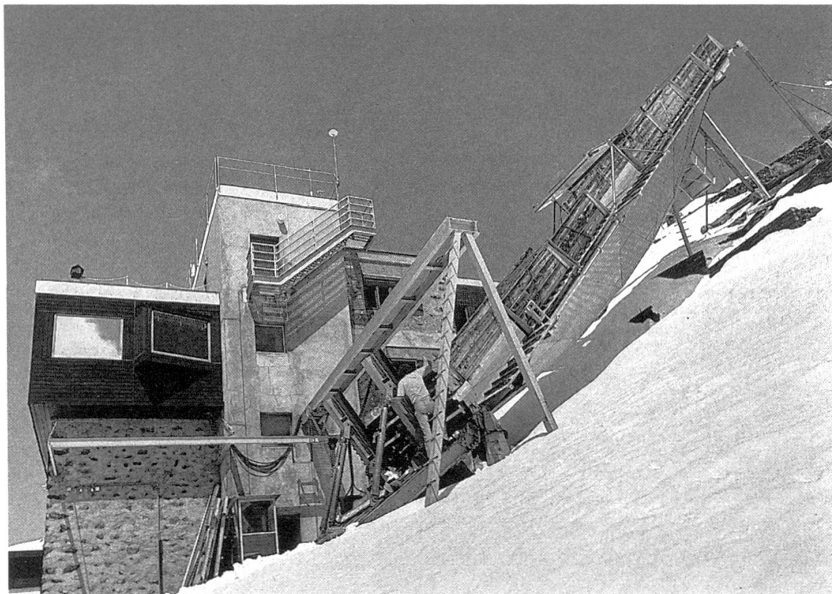
Abbildung 4. Schneegleitbahn mit eingebauten Brückenelementen (Weissfluhjoch, GR).
