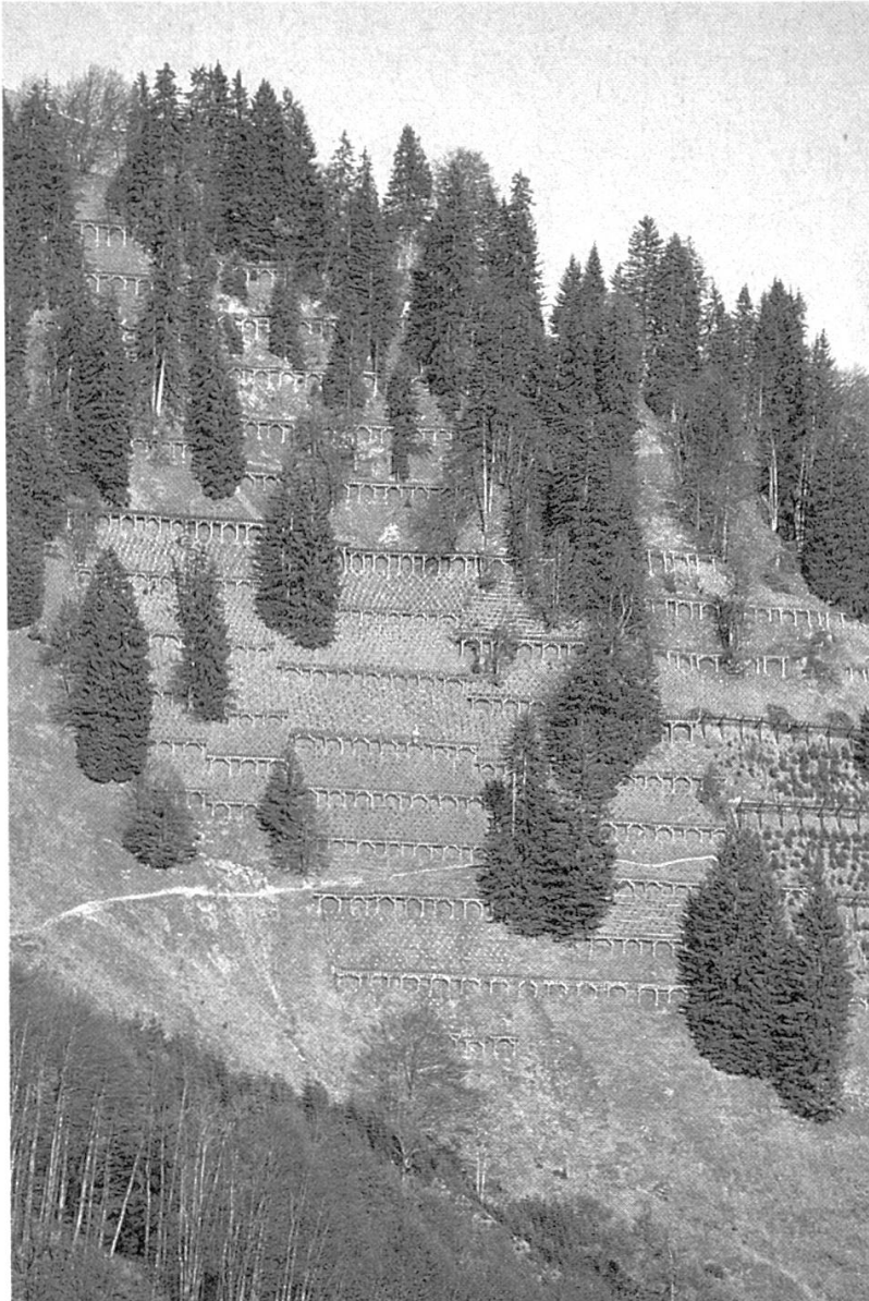
Abbildung 6. Versuchsfläche für Schneegleitschutzmass- nahmen, Gesamtansicht (Bleisa/Pusserein, GR).
