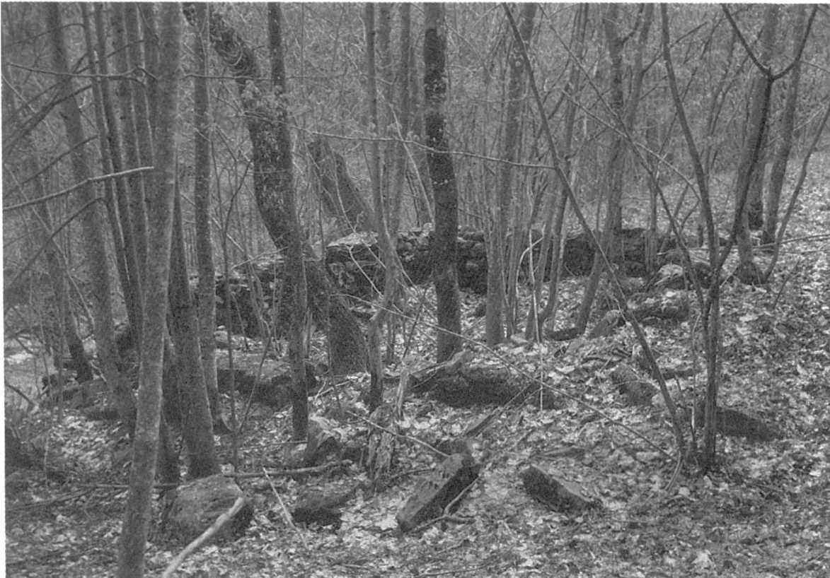
Abbildung 5. Ruine eines Stalles (Sotto Veia A), dessen Dach bereits vor mehr als 100 Jahren einstürzte. Die ältesten Bäume keimten vor 1890.
