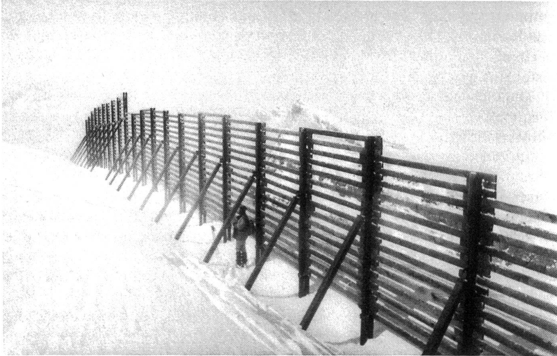
Abbildung 1. Verwehungsverbau Hinterrugg (Probeverbau und Hauptverbau, April 1992).
