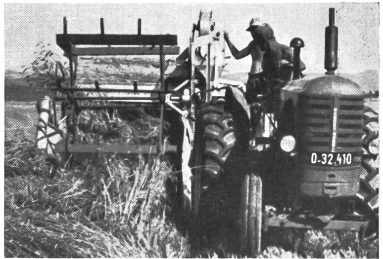
Fig. 6 Moissonneuse-batteuse dans du blé versé. Constructeur: Epple-Buxbaum SA, Wels (Autriche).
