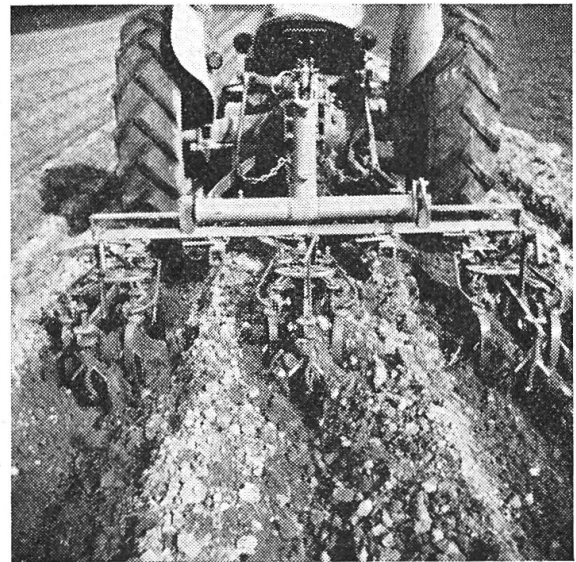
Instrument universel «Kombi» employé pour le sarclage (avec dispositif d'auto-direction)
