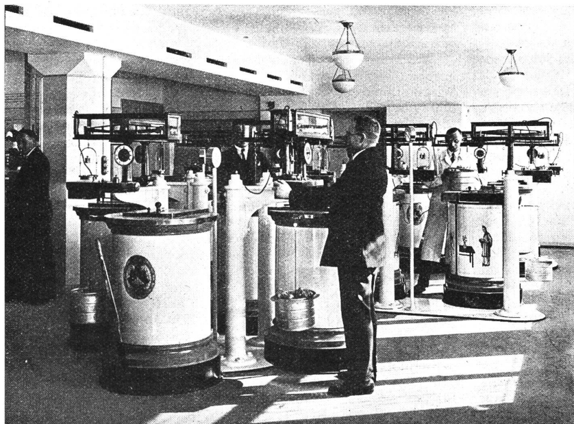
Seidentrocknungs-Anstalt Zürich, Trocknungsapparate-Saal
