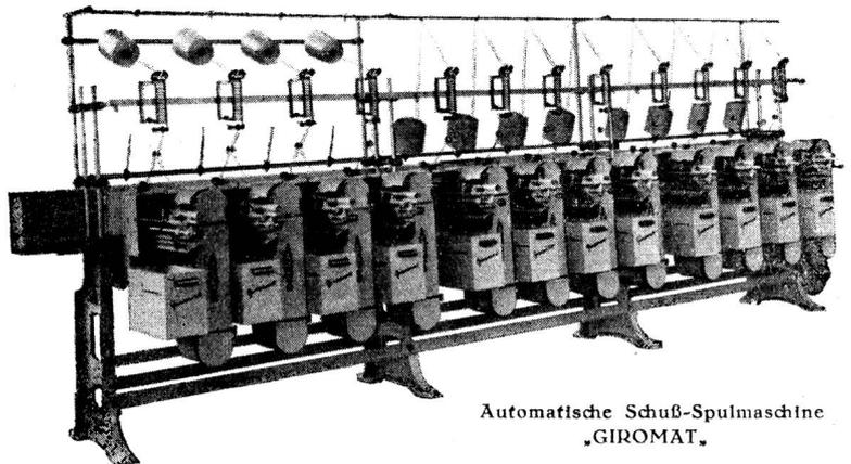
Automatische Schuß-Spulmaschine „GIROMAT“.
