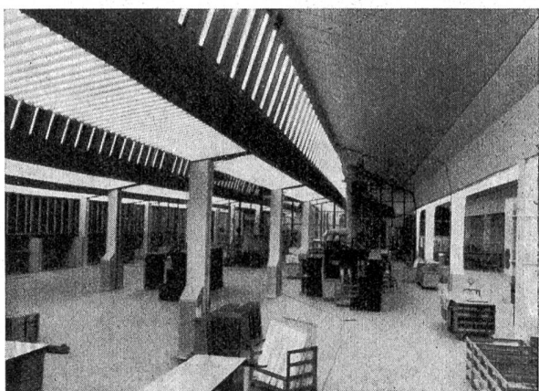
Fig. 7 Teilansicht einer Shed-Fabrikationshalle mit Blick auf die Fensterflächen. Die Beleuchtungsstärke beträgt über 1000 Lux
