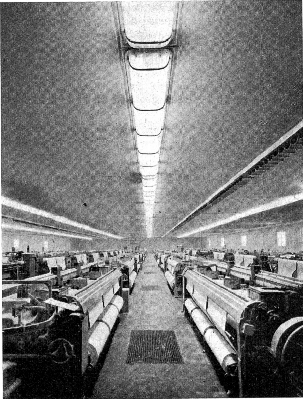
Fig. 8 Beleuchtung einer Fabrikationshalle einer Textilfabrik. Die Halle weist nur symbolische Fenster auf und ist dauernd künstlich beleuchtet, um immer gleiche Lichtverhältnisse zu haben
