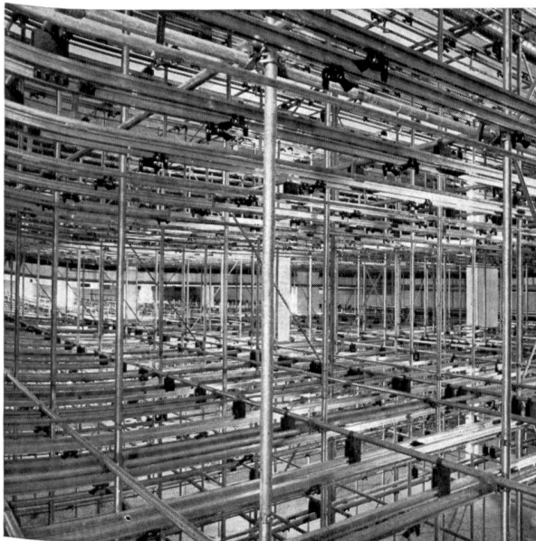
Blick auf 4etages Hängewarenlager während der Montage
