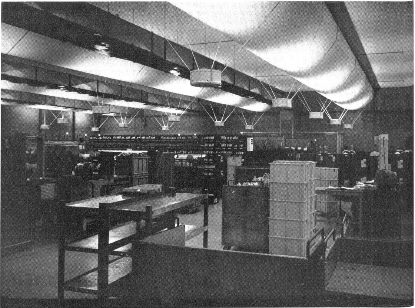
Abbildung 4 Nähfadenfabrikation in einer fensterarmen Halle mit Indirektbeleuchtung (NaH und HgI Mischlicht)
