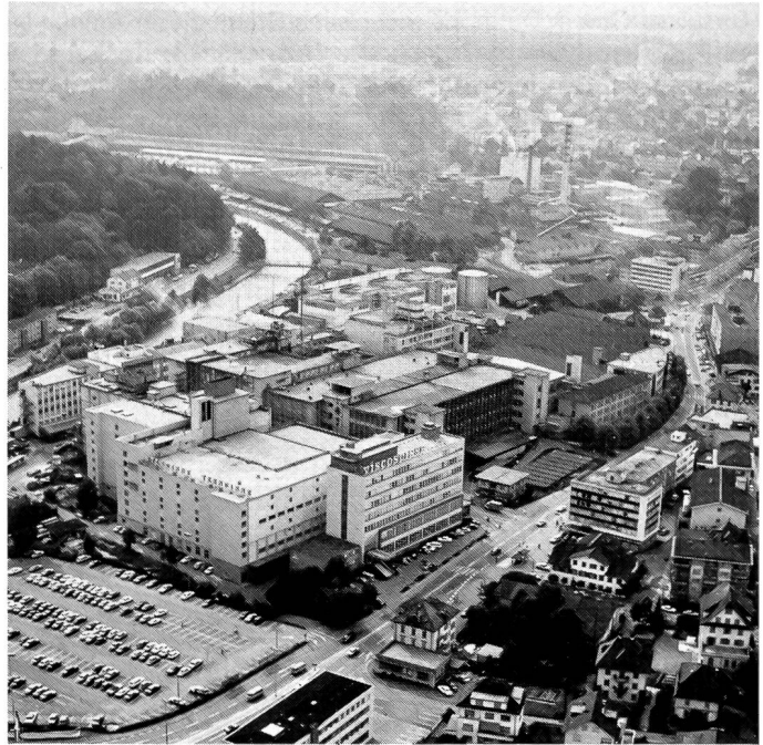
Hauptsitz der Viscosuisse AG, Emmenbrücke
