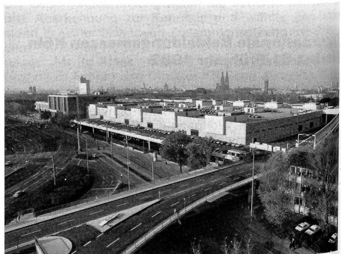
Kreuzungs- und ampelfrei führt ein Zubringer von der Autobahn direkt in das Kölner Messegelände, dessen 14 zusammenhängende Hallen eine Ausstellungsfläche von 212000 Quadratmetern umfassen.
