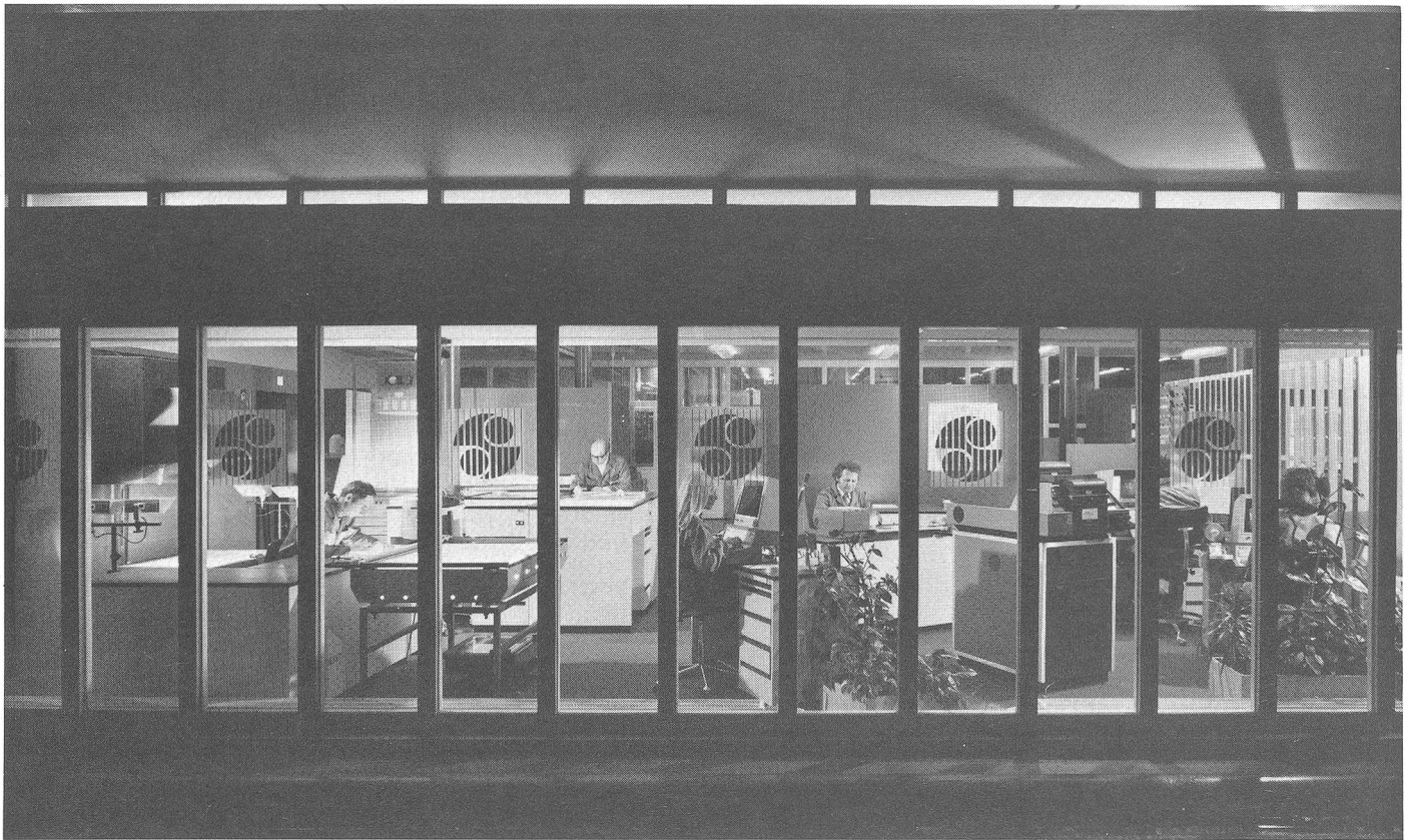
Die Neue Druckerei Speck AG ist inmitten der Stadt Zug in einem modernen Neubau an der Poststrasse 18 lokalisiert.
