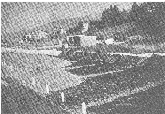
Geotextilien im Strassenbau. (Quelle: Mühlebach-Papier AG, Lupfig-Birrfeld, CH).
