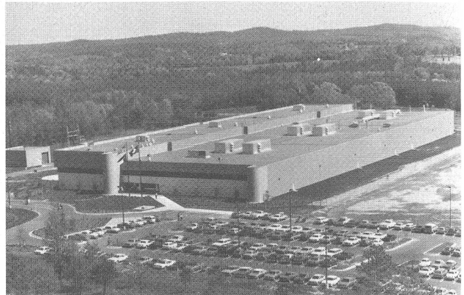
Das neue Webmaschinenwerk der Sulzer Bros. Inc. in Kings Mountain, N. C., USA
