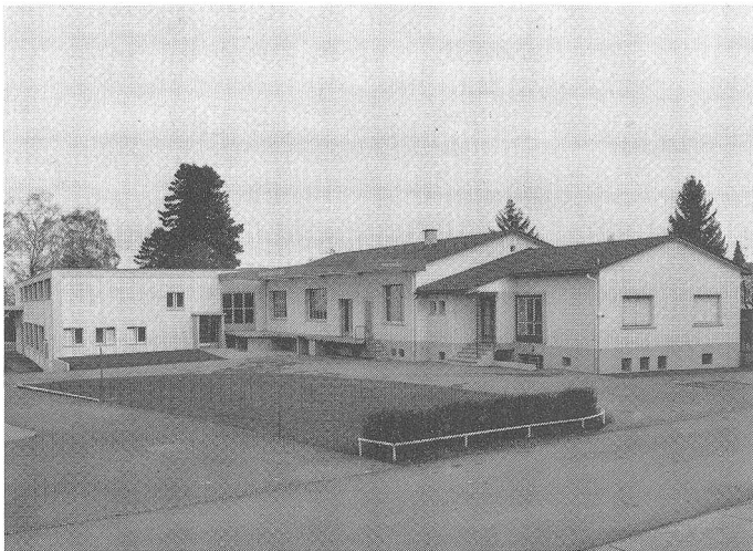
Betriebs- und Bürogebäude, links der in diesem Jahr erstellte Neubau für die Zwirnerie und die Gewebekontrolle
